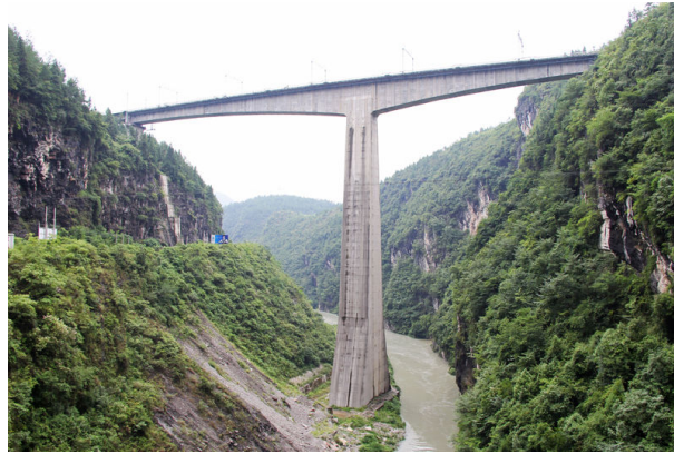
FIGURE 1 – Pont ferroviaire de Mashuihe (crédit : Eric Sakowski / Highest-Bridges.com)
