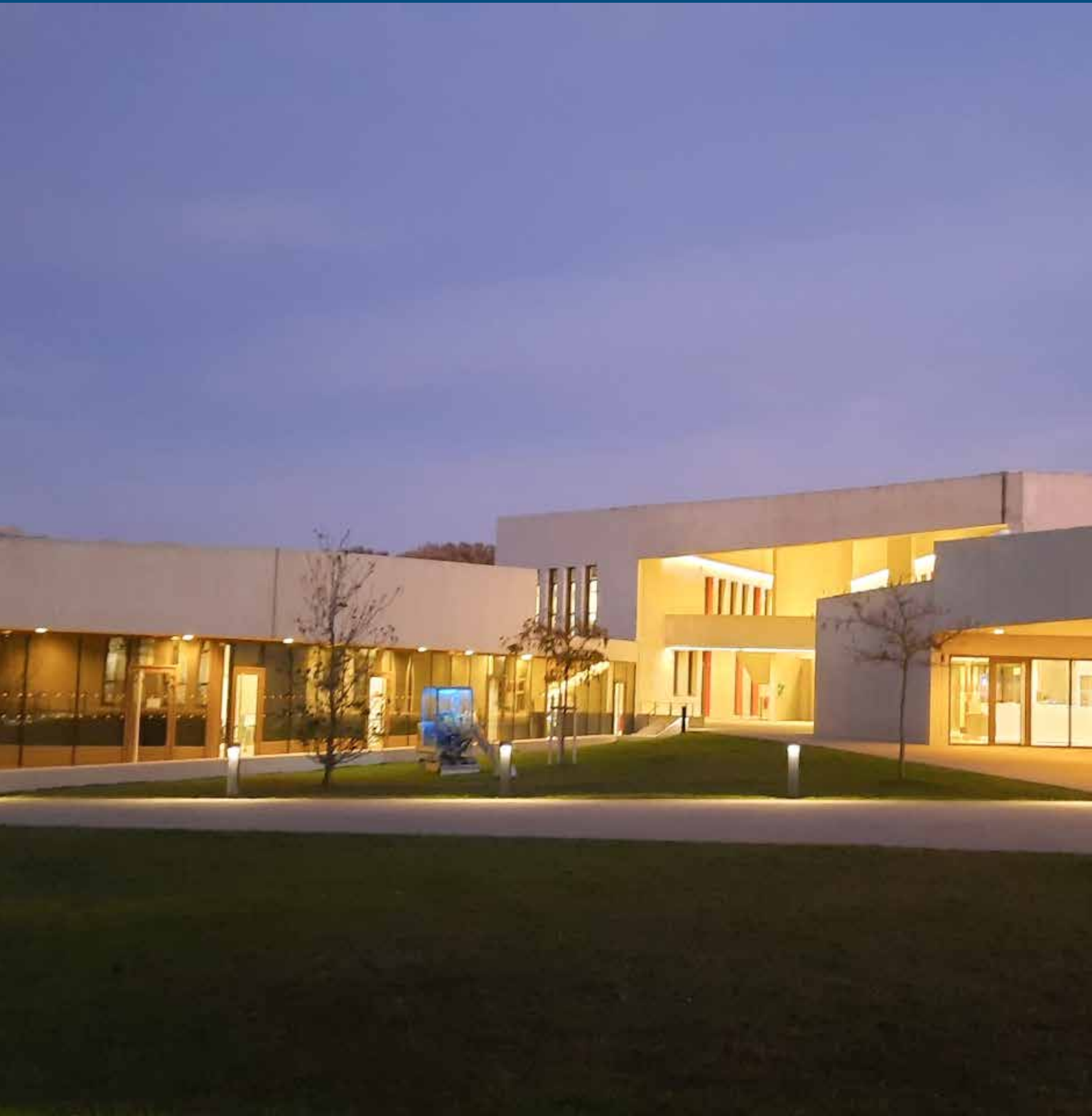
Cour intérieure du bâtiment
